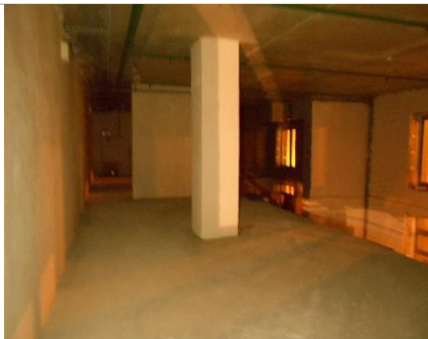
Фото 53. Внутреннее состояние помещения 667,8 кв. м.
