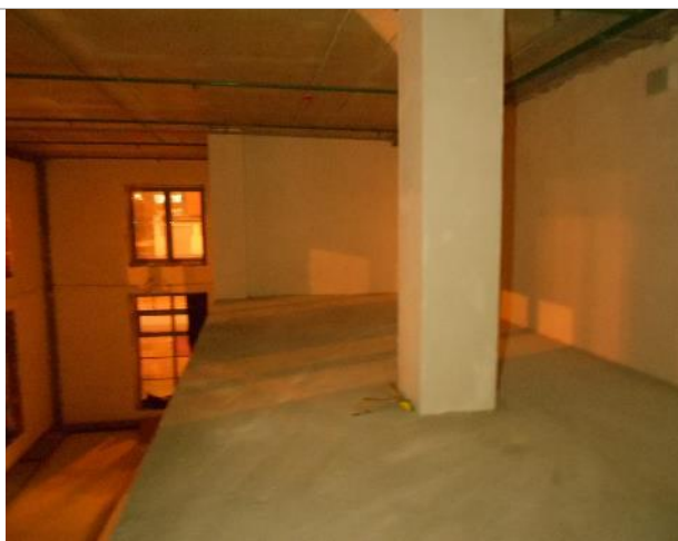
Фото 52. Внутреннее состояние помещения 667,8 кв. м.
