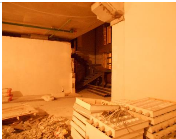
Фото 15. Внутреннее состояние помещения 667,8 кв. м.
