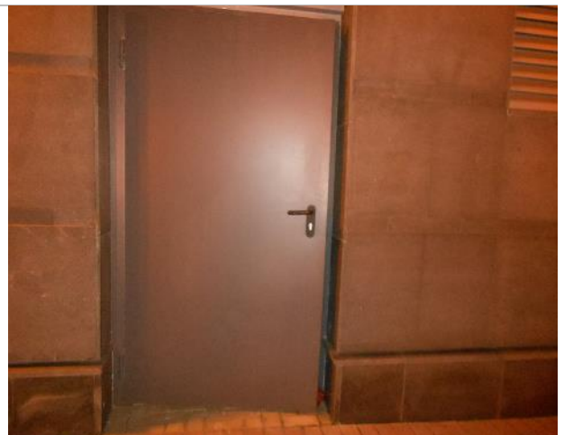
Фото 60. Запасной вход помещения 667,8 кв. м.
