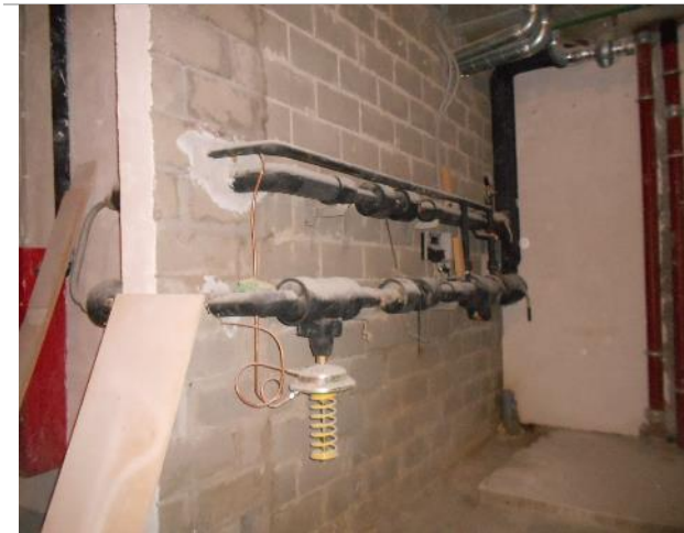
Фото 9. Внутреннее состояние помещения 667,8 кв. м.
