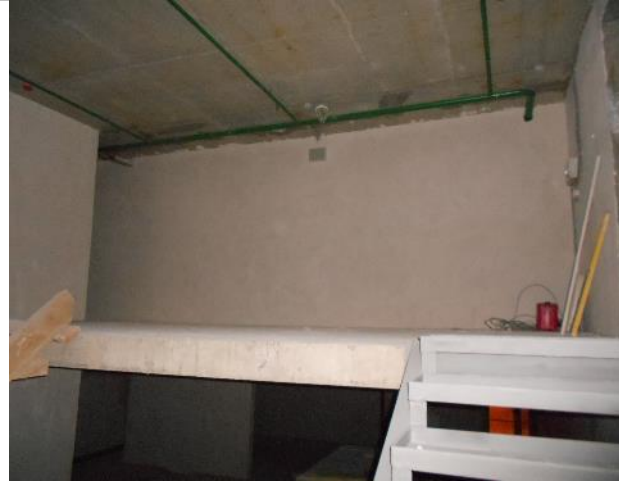
Фото 44. Внутреннее состояние помещения 667,8 кв. м.
