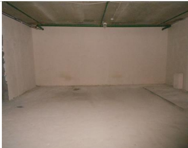
Фото 47. Внутреннее состояние помещения 667,8 кв. м.
