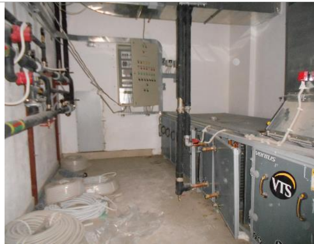
Фото 37. Внутреннее состояние помещения 667,8 кв. м.
