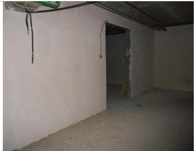
Фото 48. Внутреннее состояние помещения 667,8 кв. м.
