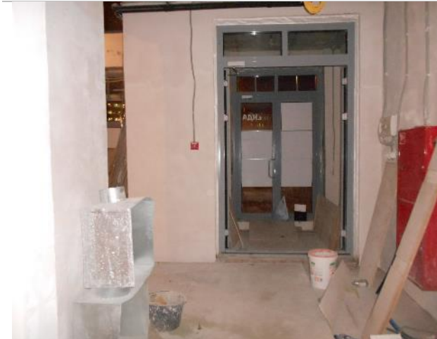
Фото 7. Внутреннее состояние помещения 667,8 кв. м.
