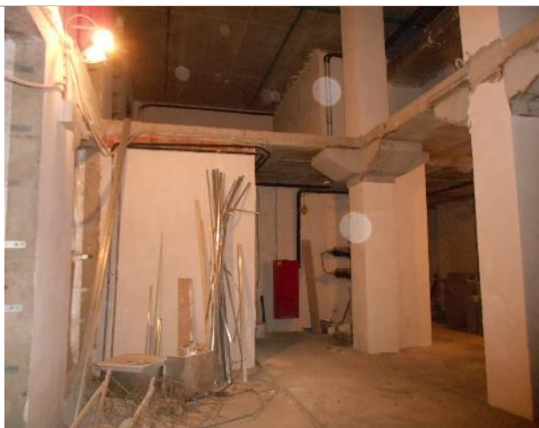
Фото 14. Внутреннее состояние помещения 667,8 кв. м.
