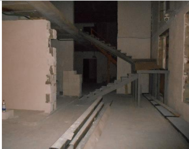
Фото 23. Внутреннее состояние помещения 667,8 кв. м.
