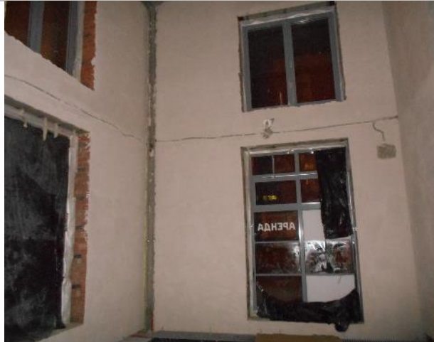
Фото 21. Внутреннее состояние помещения 667,8 кв. м.
