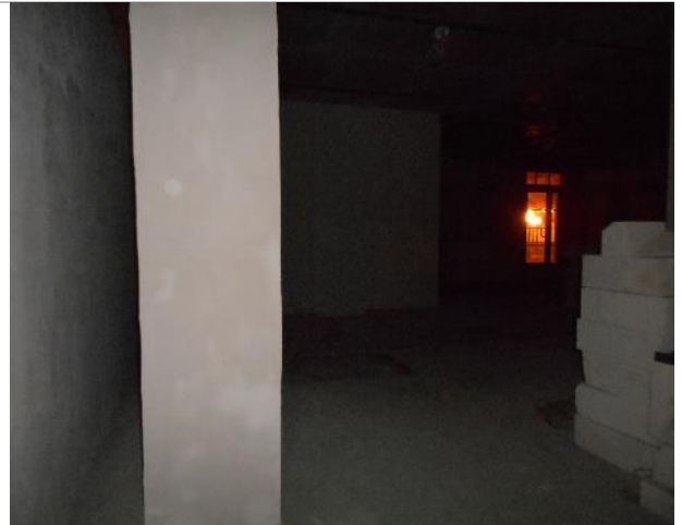
Фото 24. Внутреннее состояние помещения 667,8 кв. м.
