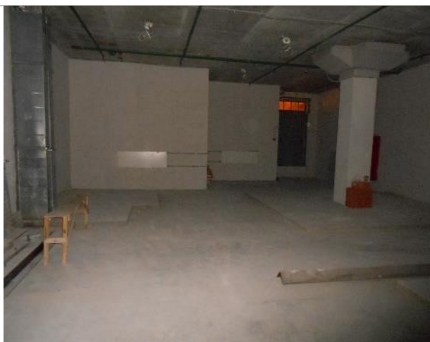
Фото 30. Внутреннее состояние помещения 667,8 кв. м.
