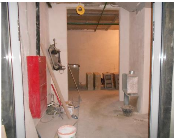
Фото 4. Внутреннее состояние помещения 667,8 кв. м.
