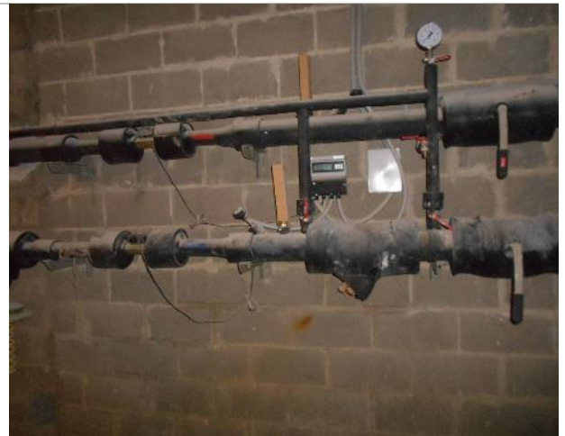
Фото 10. Внутреннее состояние помещения 667,8 кв. м.
