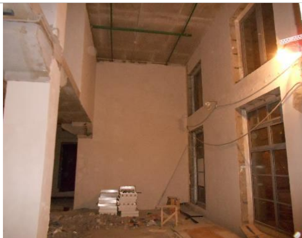
Фото 17. Внутреннее состояние помещения 667,8 кв. м.
