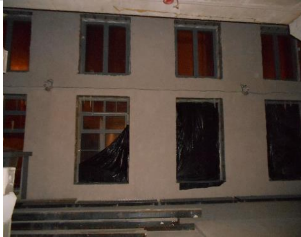
Фото 19. Внутреннее состояние помещения 667,8 кв. м.
