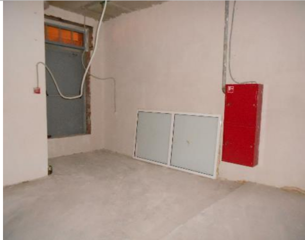
Фото 33. Внутреннее состояние помещения 667,8 кв. м.
