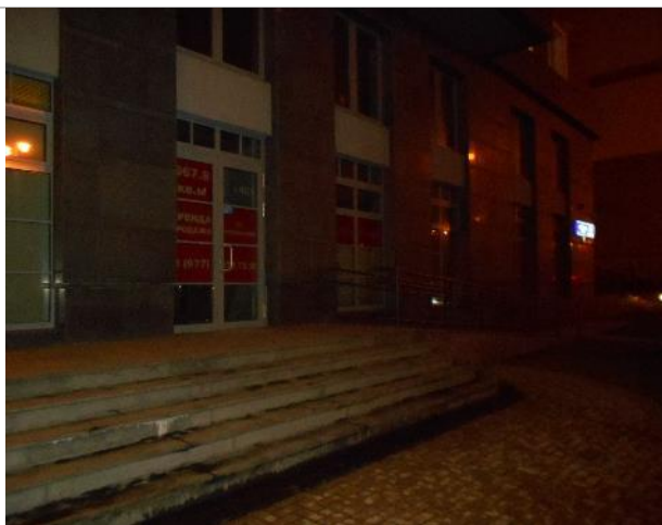
Фото 62. Запасной вход помещения 667,8 кв. м.
