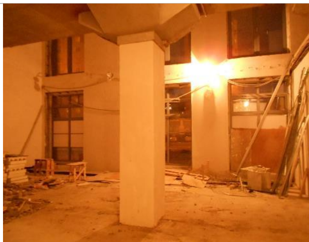
Фото 13. Внутреннее состояние помещения 667,8 кв. м.
