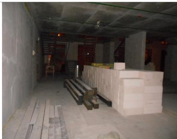
Фото 25. Внутреннее состояние помещения 667,8 кв. м.
