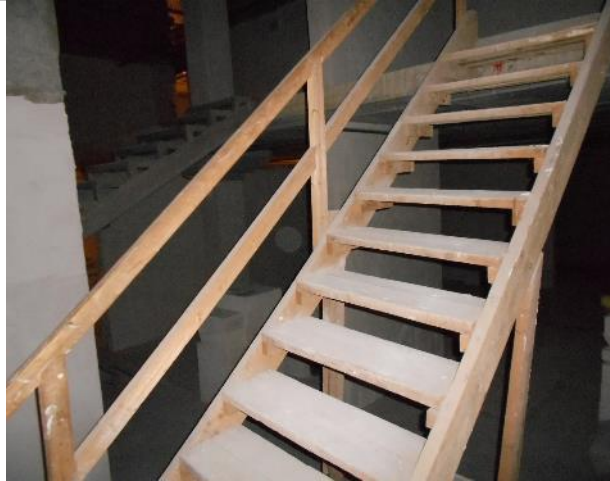
Фото 43. Внутреннее состояние помещения 667,8 кв. м.
