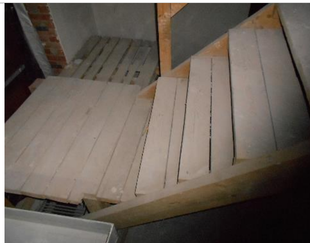
Фото 41. Внутреннее состояние помещения 667,8 кв. м.
