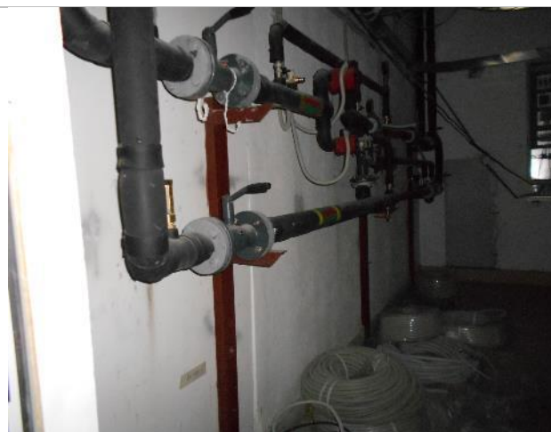
Фото 39. Внутреннее состояние помещения 667,8 кв. м.
