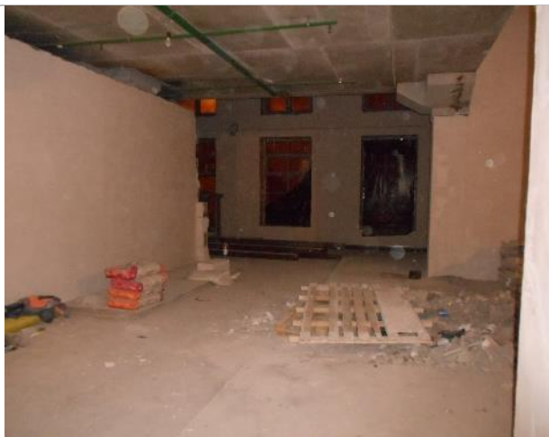
Фото 18. Внутреннее состояние помещения 667,8 кв. м.
