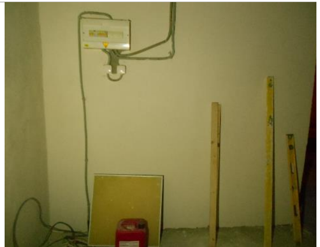
Фото 58. Внутреннее состояние помещения 667,8 кв. м.
