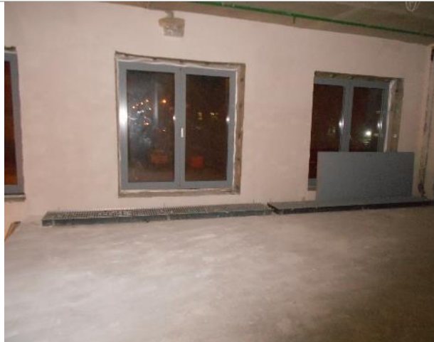
Фото 55. Внутреннее состояние помещения 667,8 кв. м.
