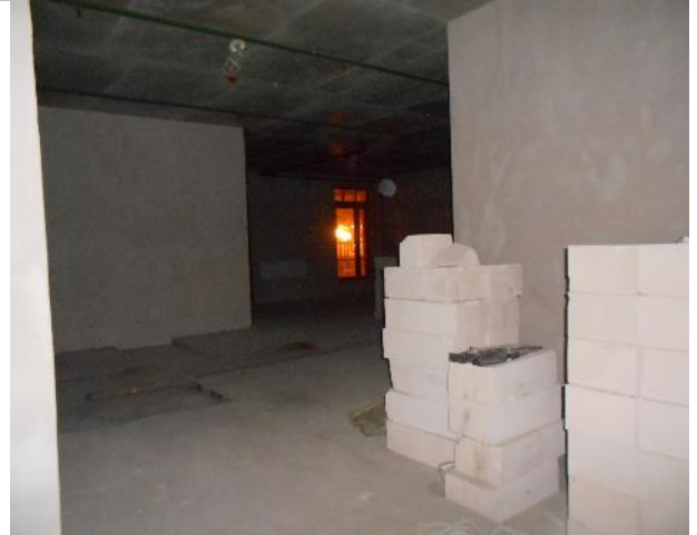
Фото 20. Внутреннее состояние помещения 667,8 кв. м.
