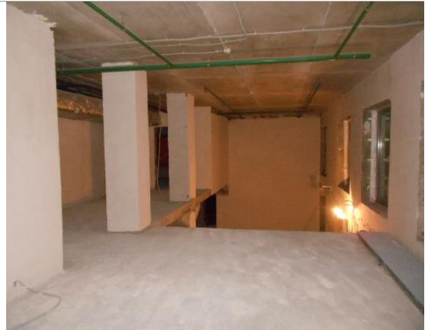
Фото 56. Внутреннее состояние помещения 667,8 кв. м.
