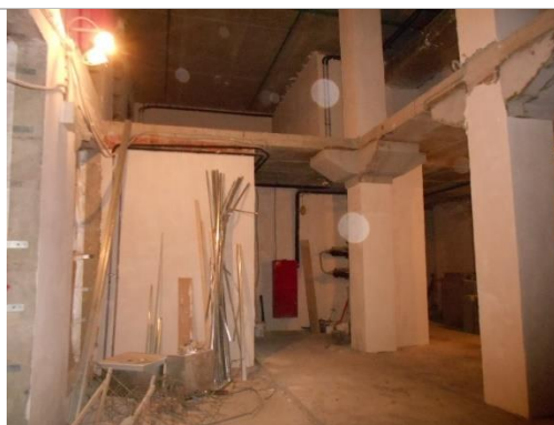
Фотография 3.4. Внутренние помещения объекта 667,8 кв. м
