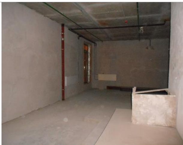
Фото 26. Внутреннее состояние помещения 667,8 кв. м.
