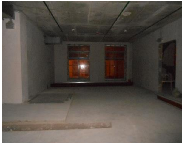
Фото 35. Внутреннее состояние помещения 667,8 кв. м.
