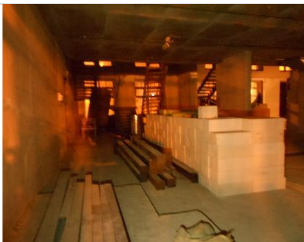
Фото 28. Внутреннее состояние помещения 667,8 кв. м.
