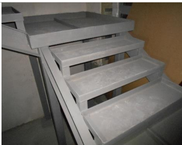
Фото 40. Внутреннее состояние помещения 667,8 кв. м.
