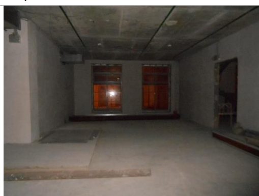
Фотография 3.5. Внутренние помещения объекта 667,8 кв. м
