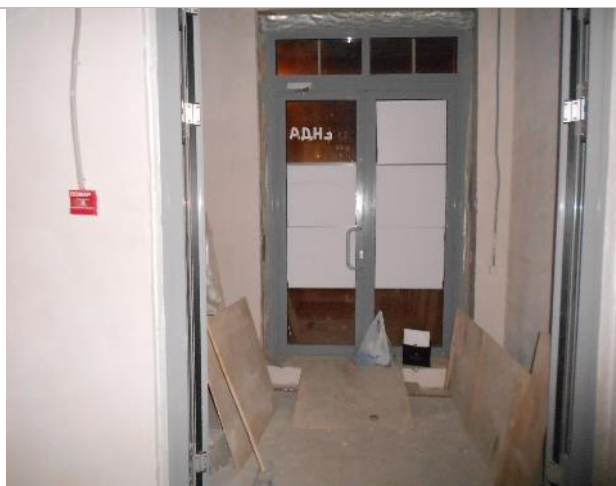
Фото 3. Внутреннее состояние помещения 667,8 кв. м.
