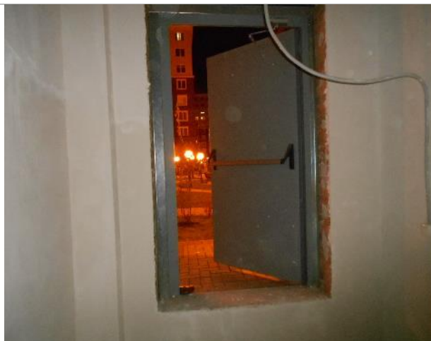
Фото 59. Внутреннее состояние помещения 667,8 кв. м.
