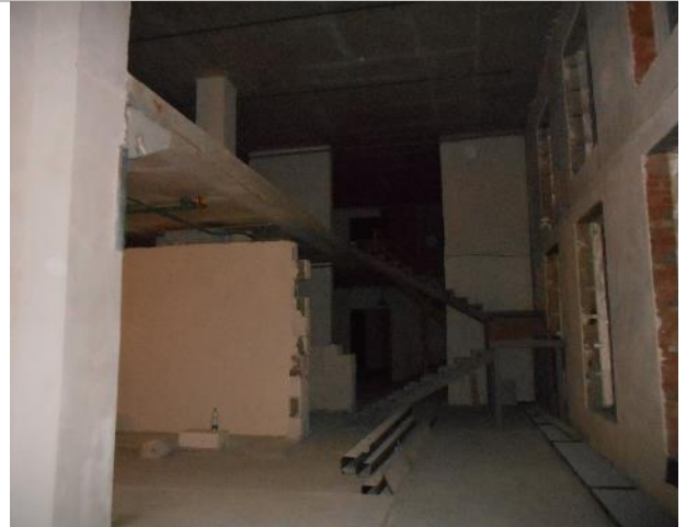
Фото 22. Внутреннее состояние помещения 667,8 кв. м.
