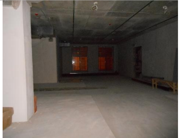
Фото 34. Внутреннее состояние помещения 667,8 кв. м.
