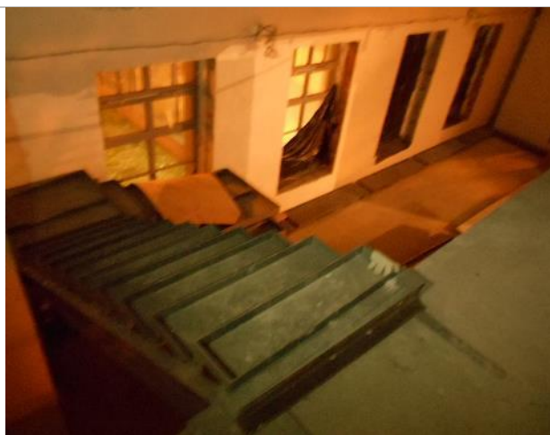
Фото 51. Внутреннее состояние помещения 667,8 кв. м.
