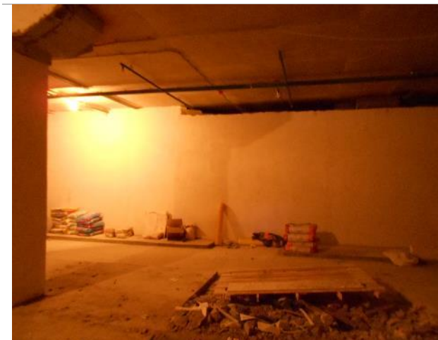
Фото 11. Внутреннее состояние помещения 667,8 кв. м.
