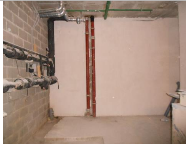
Фото 8. Внутреннее состояние помещения 667,8 кв. м.
