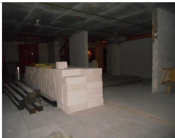
Фото 27. Внутреннее состояние помещения 667,8 кв. м.
