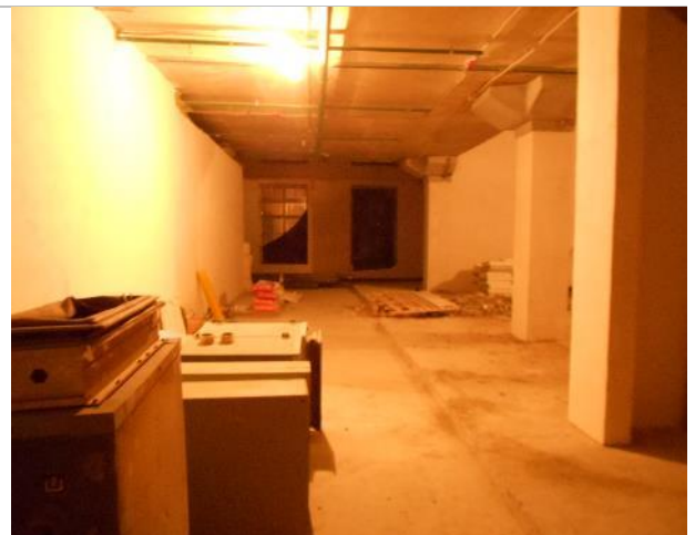
Фото 12. Внутреннее состояние помещения 667,8 кв. м.
