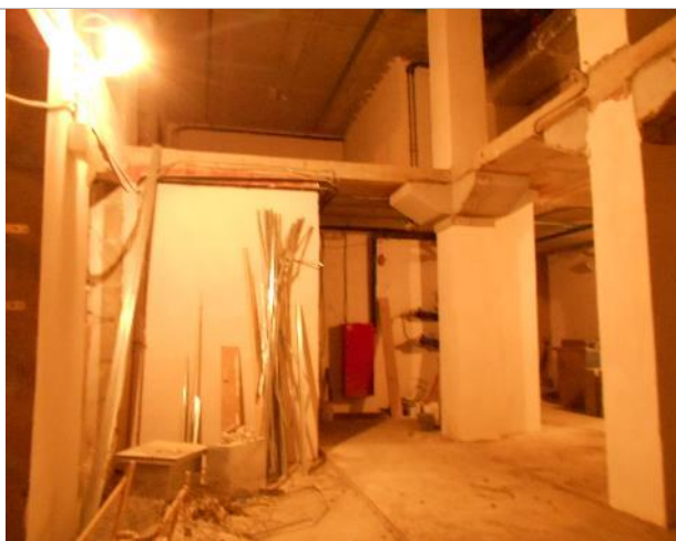
Фото 16. Внутреннее состояние помещения 667,8 кв. м.
