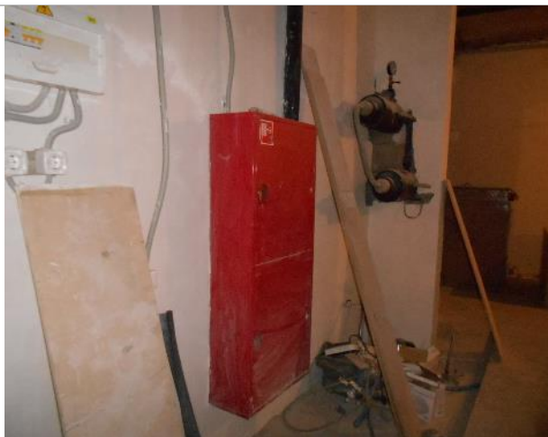
Фото 6. Внутреннее состояние помещения 667,8 кв. м.
