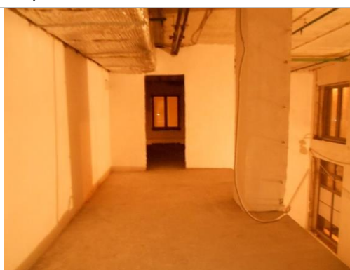
Фотография 3.6. Внутренние помещения объекта 667,8 кв. м
