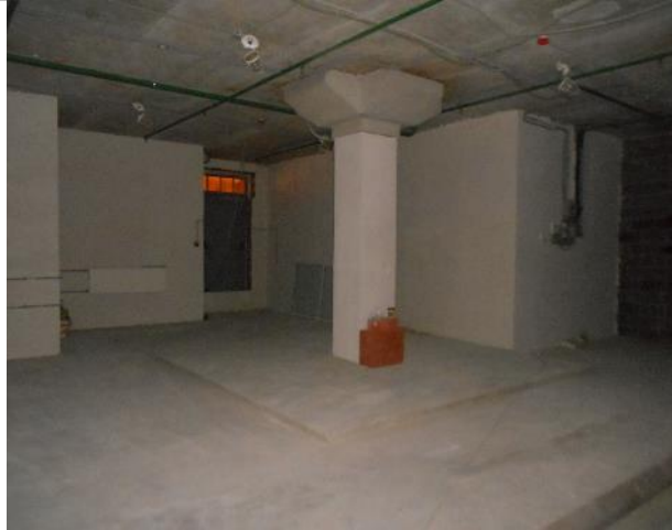
Фото 31. Внутреннее состояние помещения 667,8 кв. м.
