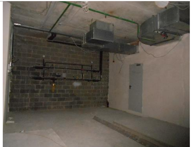
Фото 36. Внутреннее состояние помещения 667,8 кв. м.
