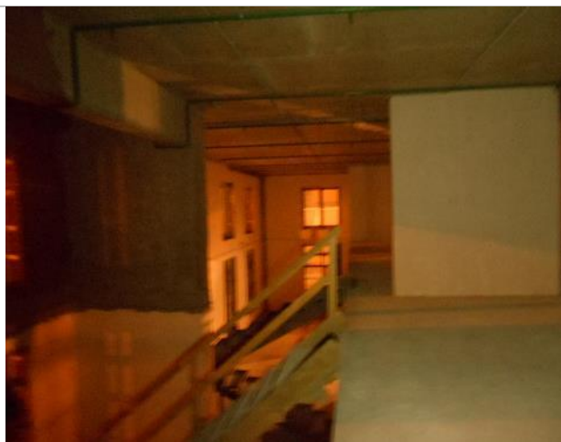
Фото 49. Внутреннее состояние помещения 667,8 кв. м.
