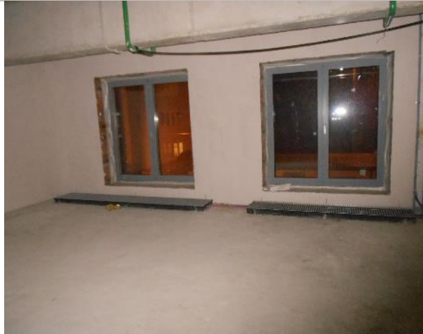
Фото 45. Внутреннее состояние помещения 667,8 кв. м.
