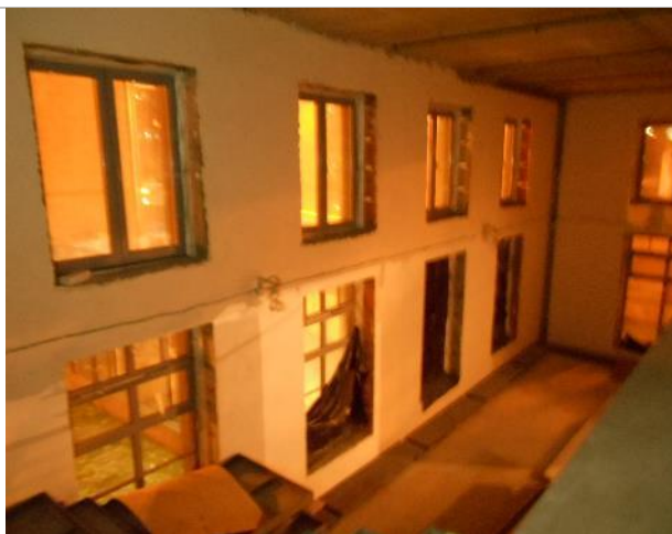
Фото 50. Внутреннее состояние помещения 667,8 кв. м.
