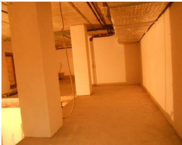
Фото 54. Внутреннее состояние помещения 667,8 кв. м.
