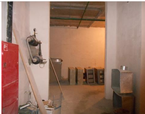
Фото 5. Внутреннее состояние помещения 667,8 кв. м.
