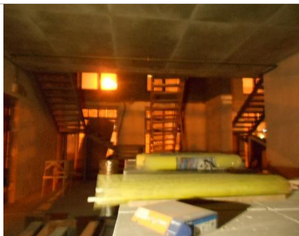
Фото 29. Внутреннее состояние помещения 667,8 кв. м.
