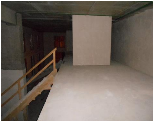
Фото 38. Внутреннее состояние помещения 667,8 кв. м.
