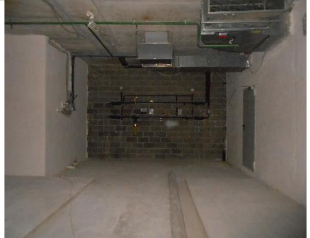
Фото 32. Внутреннее состояние помещения 667,8 кв. м.
