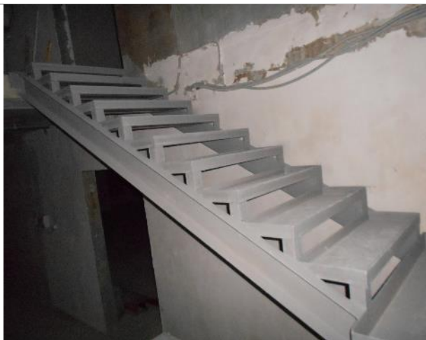
Фото 42. Внутреннее состояние помещения 667,8 кв. м.
